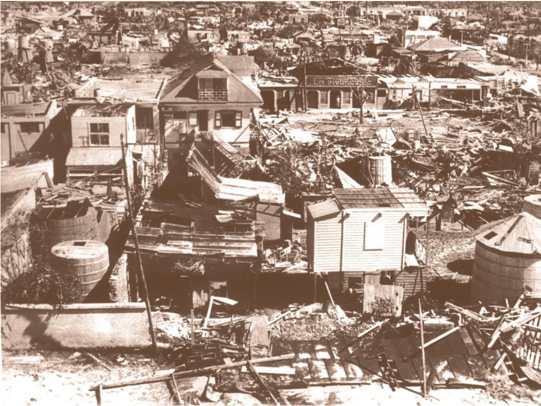
Figura 5.1. Afectaciones a curbatos por el huracán Janet
