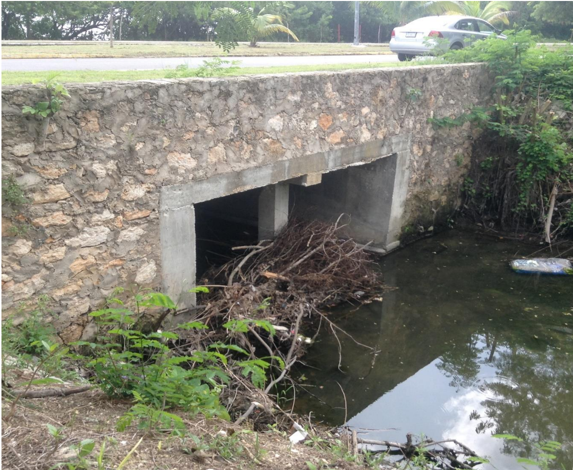
Figura 5.5. Colector pluvial azolvado
