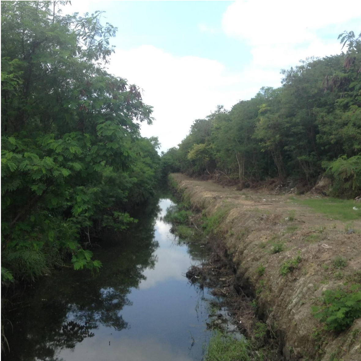
Figura 5.3. Primer colector de drenaje pluvial a cielo abierto.
